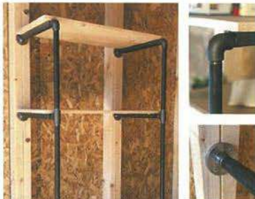
2段ラック パイプ受け フランジ部分
